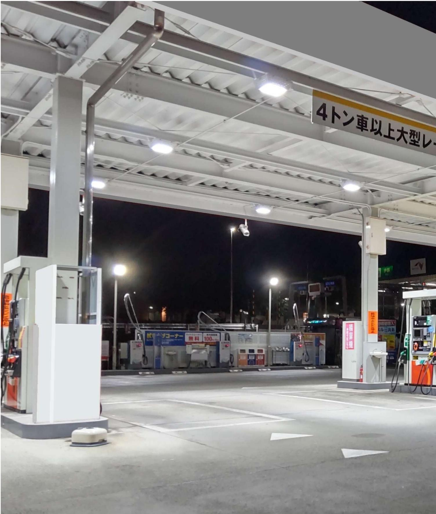
水銀灯からLED照明へ、旧LED照明から新LED照明へ
